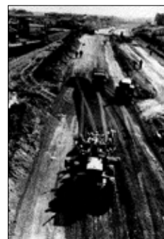
昭和48年(1973) 建設中の保土ヶ谷バイパス
