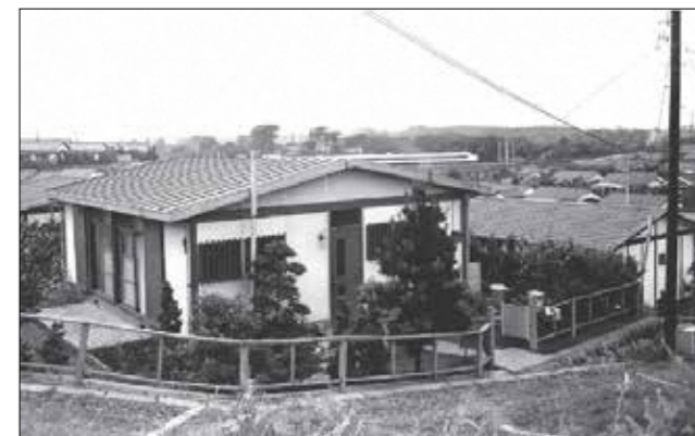
万騎が原団地で採用したプレハブ住宅 (提供/相鉄グループ)
