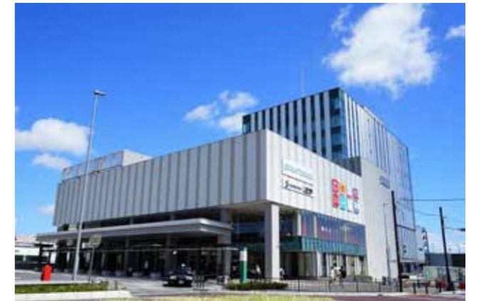
ジョイナステラス二俣川(二俣川駅南口) (提供/相鉄グループ)
