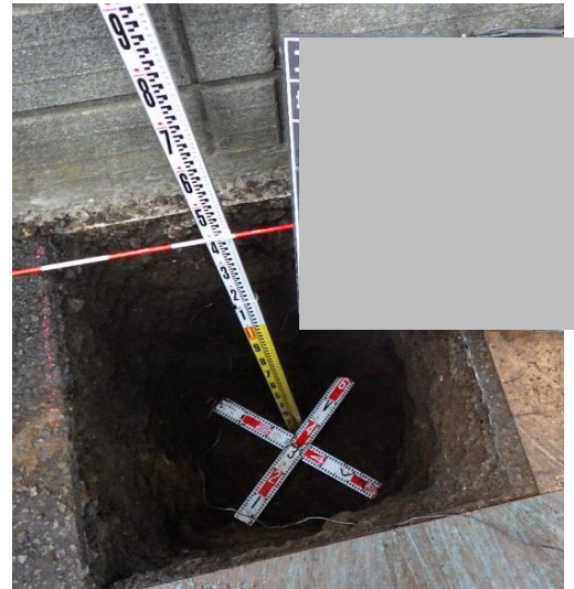
鋼管ポール設置工事の様子
