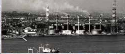
Nhà máy nhiệt điện Yokohama (trước)
