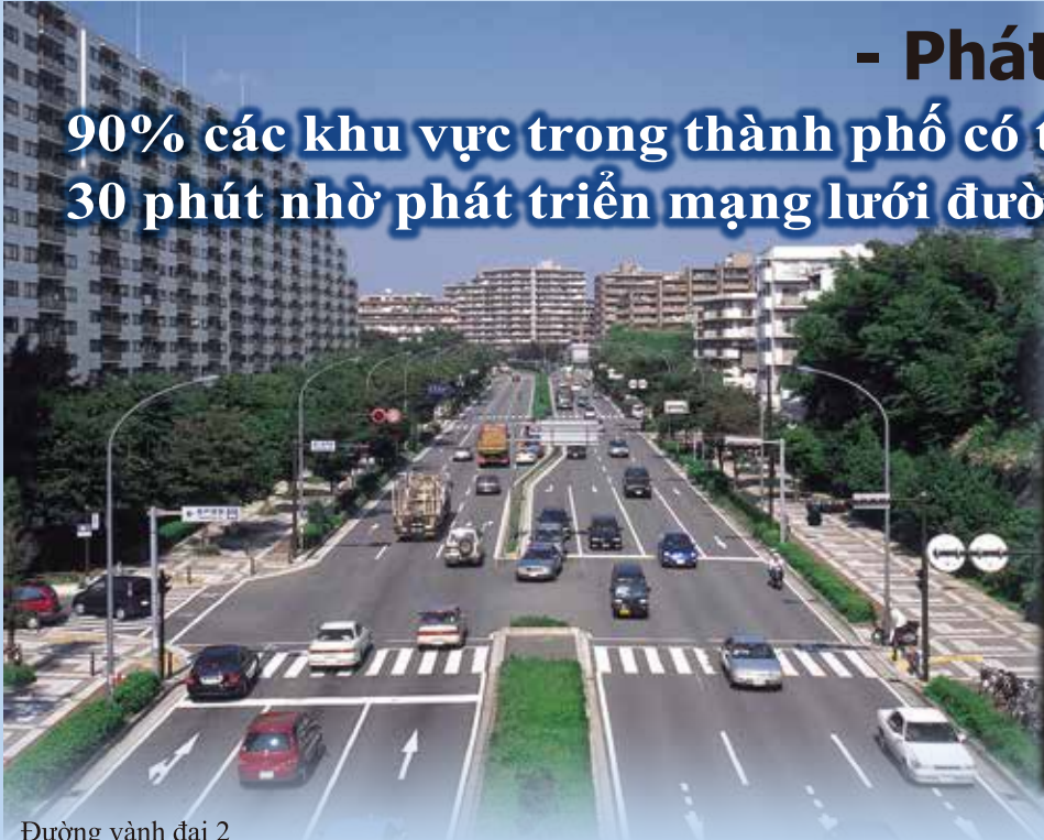
Đường vành đai 2
