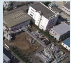
福浦工場排水処理場
