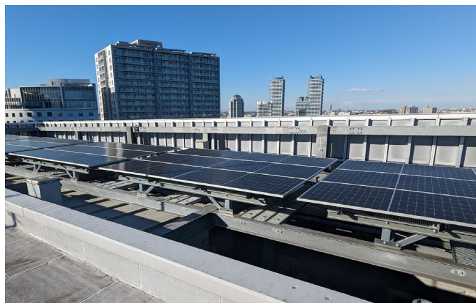
地区内施設への太陽光発電設備設置
