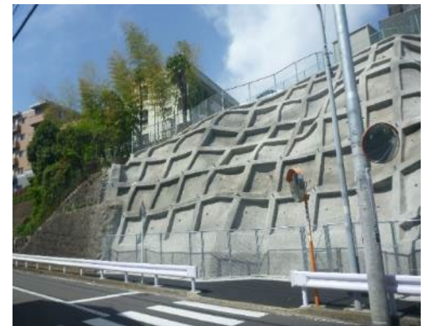
< 道路がけ防災対策後 >
