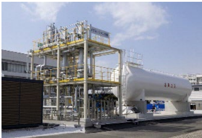
ごみ焼却工場の排ガスからのCO 2 回収とメタネーションへの利用実証（CCU）
