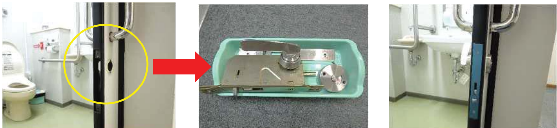
多目的トイレの施錠交換
