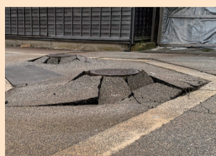
◀能登半島地震にて液状化により浮上したマンホール(石川県志賀町)
