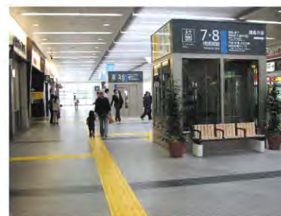
大船駅(北改札)エレベーター設置
