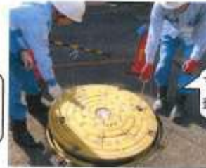
マンホールの 回りに安全柵 を設置します。
