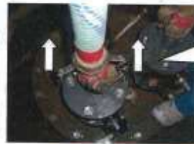
5-① 給水栓室に入り、締付レ バーを下げて緩給水栓の蓋 を緩め取り外します。
