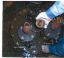
5-① 給水栓室に入り、締付レ バーを下げて緩給水栓の蓋 を緩め取り外します。
