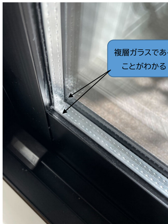
②斜めから撮影した写真
