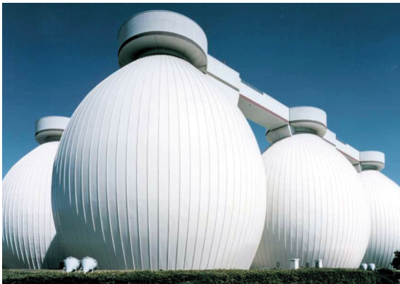
消化タンク（北部汚泥処理センター）
