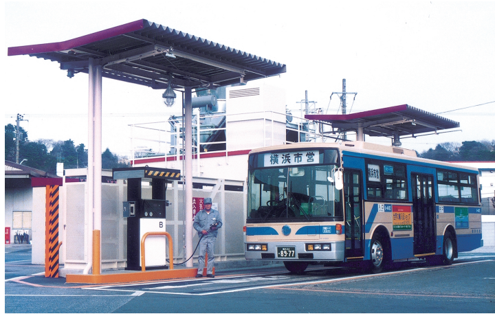
天然ガスバスと天然ガス充てん所（交通局滝頭営業所）
