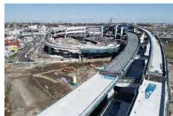
整備中の横浜北西線（横浜港北 JCT）
