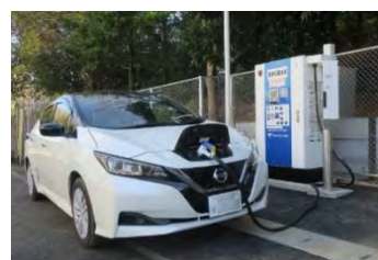
急速充電設備（都筑区）
