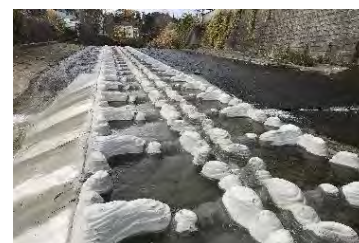
整備した魚道（帷子川）
