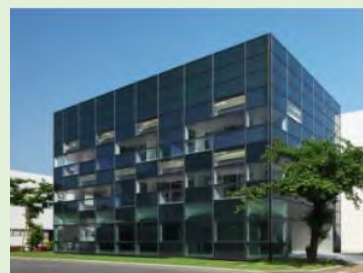
大成建設株式会社のZEB実証棟* (戸塚区)
