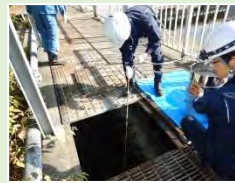
調査の様子 (神奈川水再生センター)
