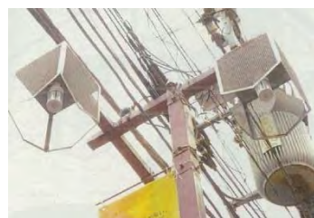
LED 照明に交換した街路灯 (日吉中央通り会 (港北区))
