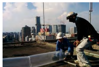
アスベスト除去作業の立入調査の様子
