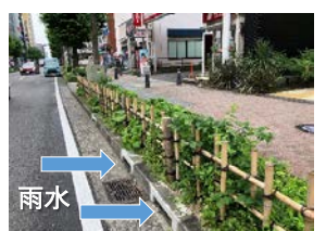
雨水を引き込みゆっくり浸透させ植栽の良好な生育に活用するグリーンインフラの取組（港北区）
