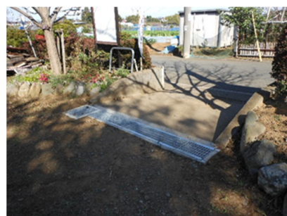
【側溝の整備】 鴨居原市民の森（緑区）
