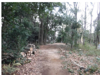
【危険樹木の伐採】 大貫谷公園（旭区）
