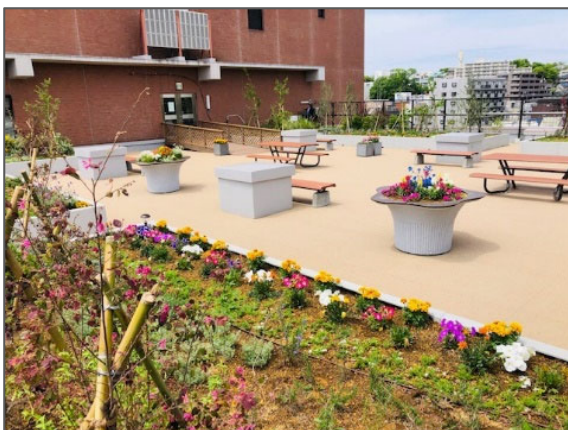
17 公共施設・公有地での緑の創出・育成 (港北区庁舎)
