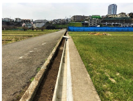
【水路の再整備】（青葉区）
