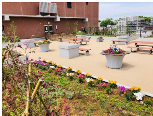
港北区庁舎（屋上）（港北区）
