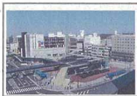
戸塚駅西口第1地区 市街地再開発事業（施行中）
