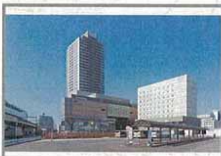
鶴見駅東口地区 市街地再開発事業（完了）
