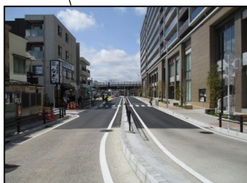
拡幅された道路
