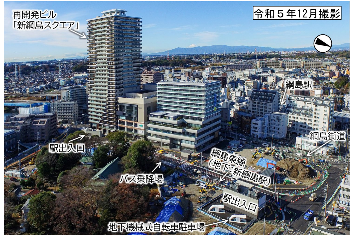
新綱島駅周辺地区の状況
