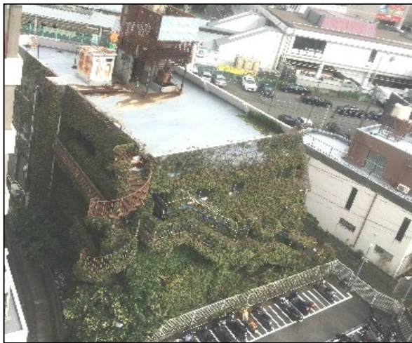
老朽化した建物
