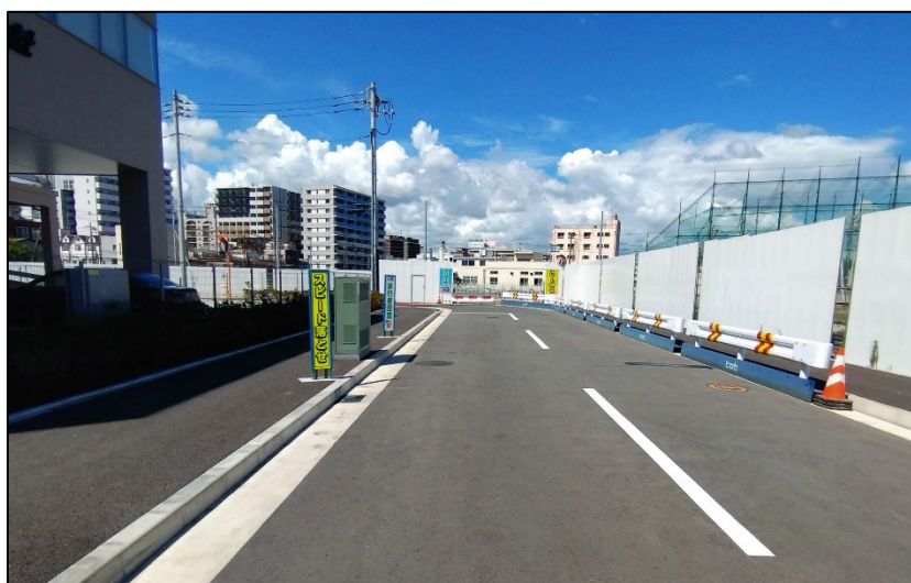
地区内道路の一部完成
