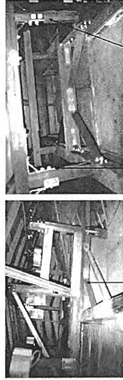
過剰な火打ち金物・束やもやに取り付けられた不必要な金物
