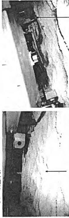
東石が埋まるくらいまで調湿材を入れ、東が湿気で腐る心配がある。東に銅板巻き付
