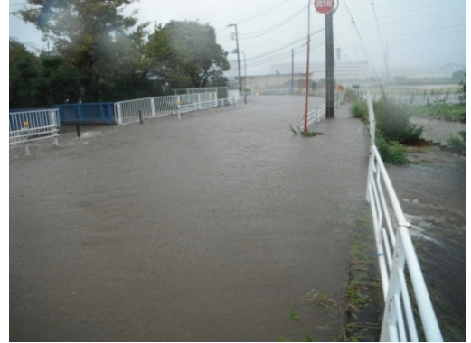
【田谷地区の浸水状況】 （平成26年台風第18号）
