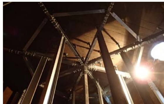
防火水槽補強工事
