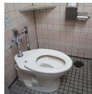
洋式化改修後
