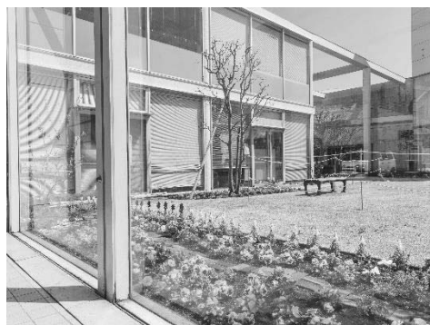
下和泉地区センター（泉区）
