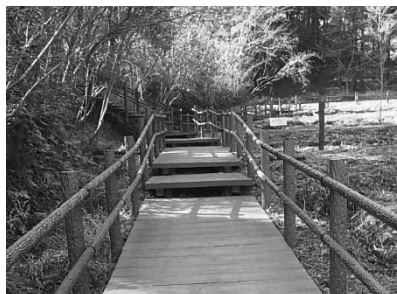
【安全確保のための柵の整備】 新橋市民の森（泉区）
