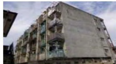
建物の痛みが著しく外壁の剥離、手すりの崩落などが見られる事例 資料：国土交通省社会資本整備審議会住宅地分科会資料
