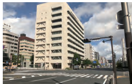
沿道建築物の耐震化
