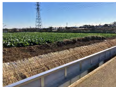
【土留め柵を設置した農地】（都筑区）
