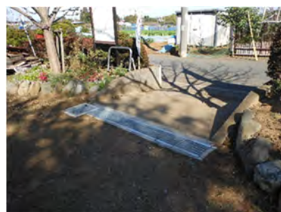
【側溝の整備】 鴨居原市民の森（緑区）
