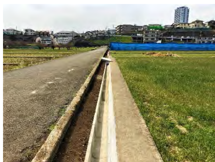
【水路の再整備】（青葉区）
