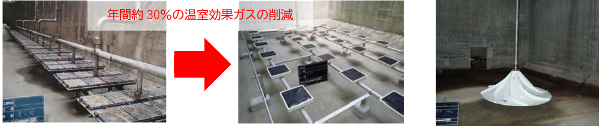
従来型の散気板と最新の散気設備（低圧膜型メンブレン）の比較
