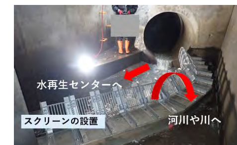
雨水吐の改良状況
