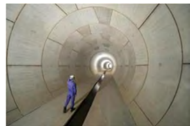
雨水貯留施設（新羽末広幹線）の内部
