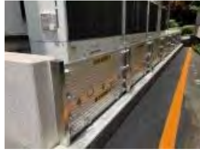
機械設備の耐水化（止水板）
