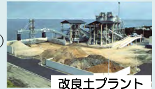
改良土プラント
