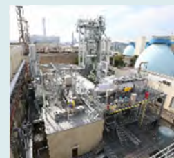
下水汚泥燃料化施設
