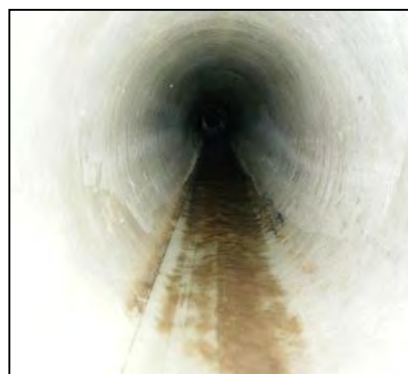
更生後の下水道管
