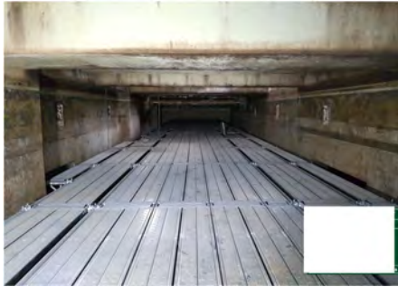
最初沈殿池での防食被覆更新（左：施工前、右：施工後）
