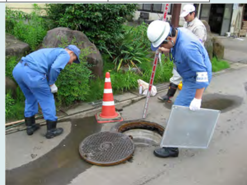
新潟県中越沖地震 調査時の様子
