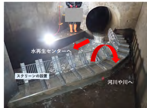
雨水吐の改良状況
