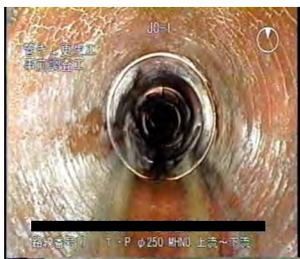
更生前の下水道管
