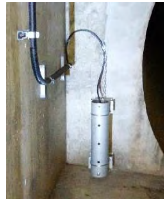
水位計設置状況
