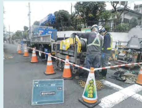
管更生の施工状況
