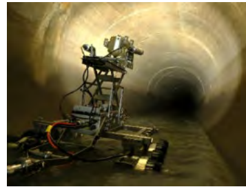
中大口径管の調査状況
