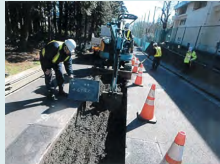
布設替の施工状況
