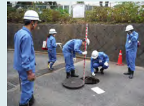
下水道管実地調査訓練
