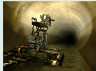
中大口径管の調査状況
