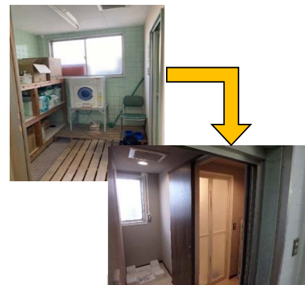
<執務環境改善（浴室改修）>
