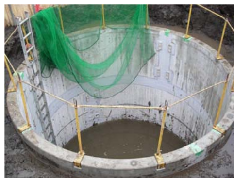
<防火水槽新設工事>
