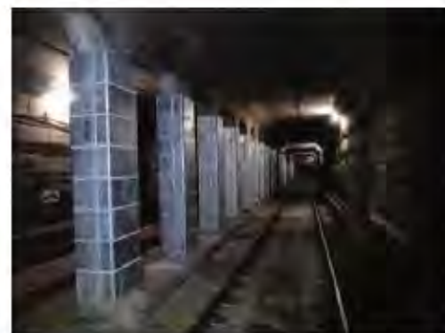
トンネル柱耐震補強
