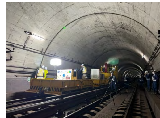
レーザーによる打音検査
