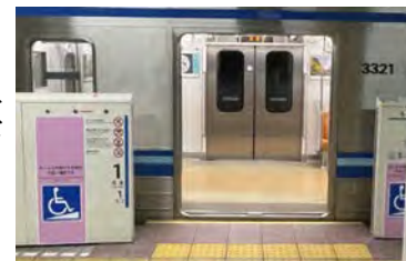
段差・隙間縮小
