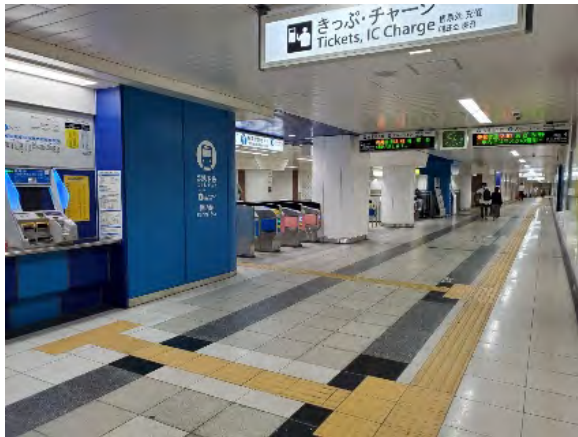
改良工事後関内駅
