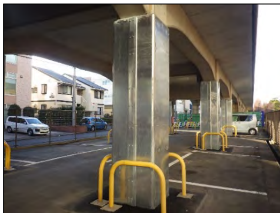
耐震補強状況（高架部）
