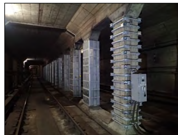
耐震補強状況（開削トンネル部）
