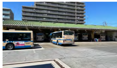
緑営業所車両整備工場
