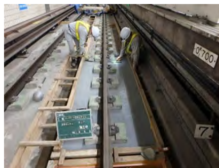
軌道改良工事
