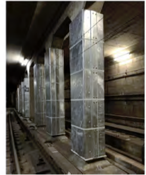
トンネル部の耐震補強工事
