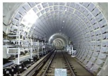
シールドトンネル補修
