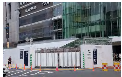
横浜駅西口駅前広場工事仮囲い
