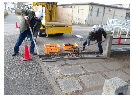
＜側溝の清掃作業＞
