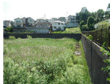
三保第一雨水調整池(現状)
