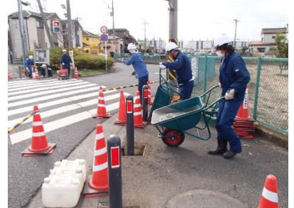
<土木事務所の作業風景>
