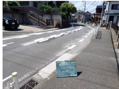
補修：外側線（上山町）
