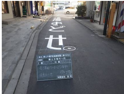
新設：路面標示（長津田）
