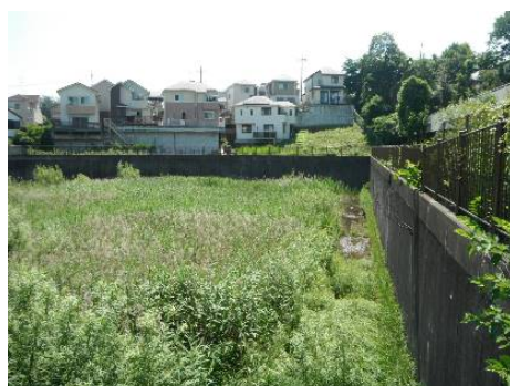
三保第一雨水調整池（現状）
