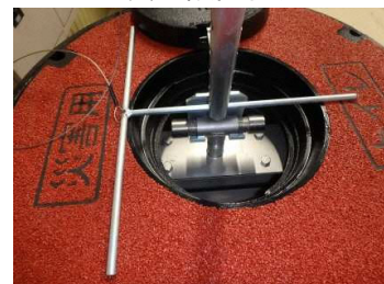
治具の設置状況
